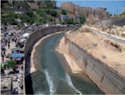
Abou Ali Canal en Béton
